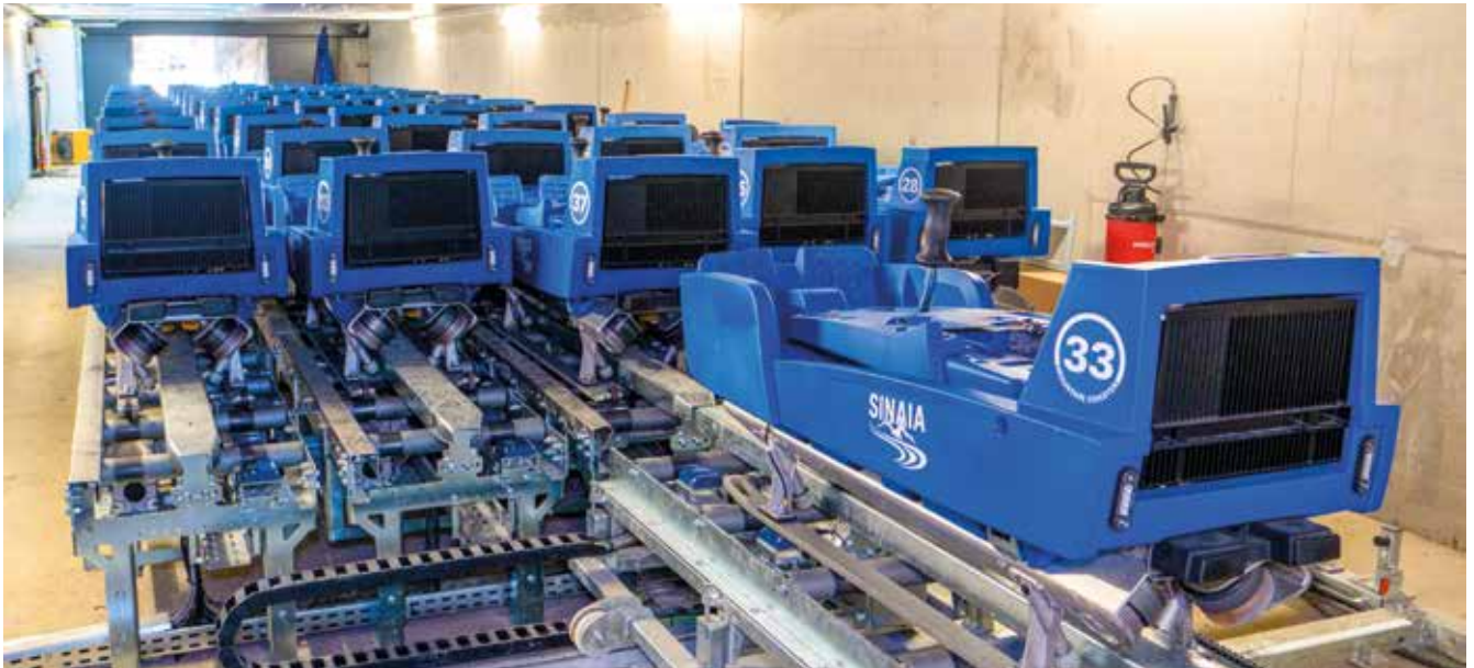
Vollautomatische Garagierung Rimessaggio completamente automatico
